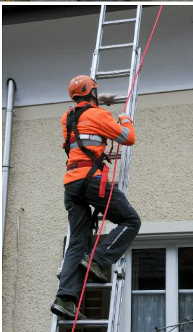
Mitlaufendes Auffanggerät EN353-2 mit EN341 Ablassfunktion (Rettung)
