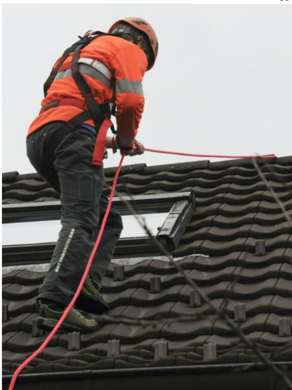
Mitlaufendes Auffanggerät EN353-2 mit EN341 Ablassfunktion (Rettung)
