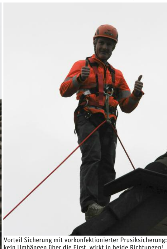
Mitlaufendes Auffanggerät EN353-2 mit EN341 Ablassfunktion (Rettung)
